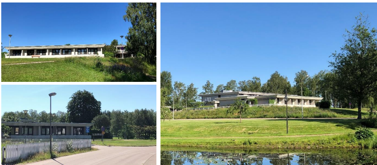
Figur 15–17. Sjögårdens serviceboende, befintlig byggnad (2019).
